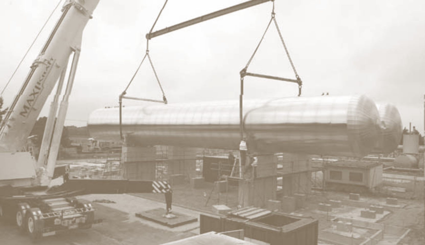
Montage von Kohlendioxidtanks auf einer Versuchsanlage in der Altmark/Sachsen-Anhalt. Foto: Vattenfall
