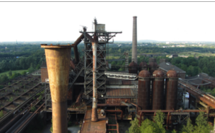
Als noch Stahl und Kohle dominierten. Die Hinterlassenschaften der Schwerindustrie im Landschaftspark Nord in Duisburg (Foto: Michael Reckordt)
